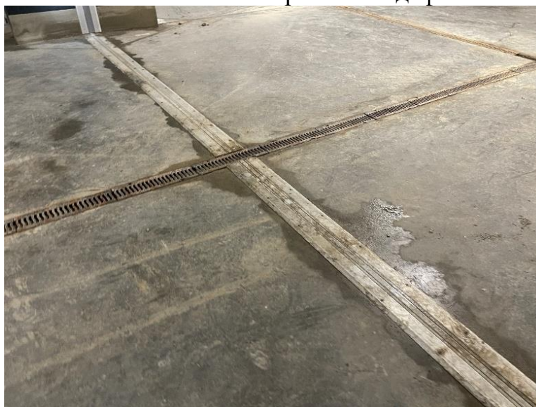
Рисунок 2. Активные течи через зону деформационного шва
