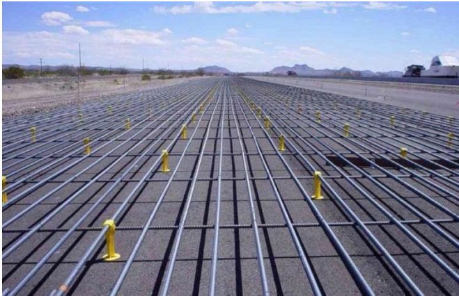
Рис.1 Армирование дороги перед заливкой бетона
