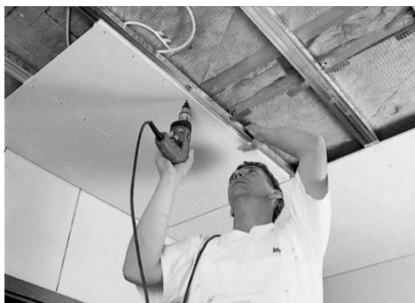
Рис. 2. Монтаж листов ГКЛ на металлический профиль
