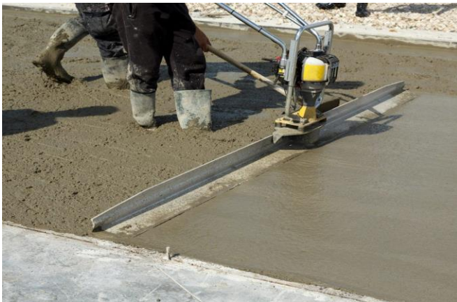
Рис.2 Разравнивание-уплотнение бетонной смеси.
