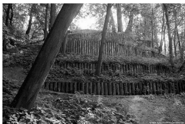
Рис.4 Укрепление откосов бревенчатыми террасами в музее-заповеднике «Коломенское», г. Москва
