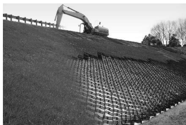
Рис.3 Укрепление склонов георешеткой
