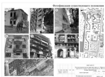
Рис. 1. Фотофиксация существующего положения поврежденной жилой застройки в г. Мариуполь
