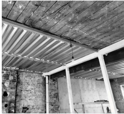
Рис. 3. Демонтаж чернового потолка из дерева. Усиление балок потолка стойками и распределительной балкой
