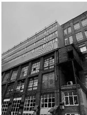
Рис.2. Новые пристройки по внутреннему фасаду Электрозавода
