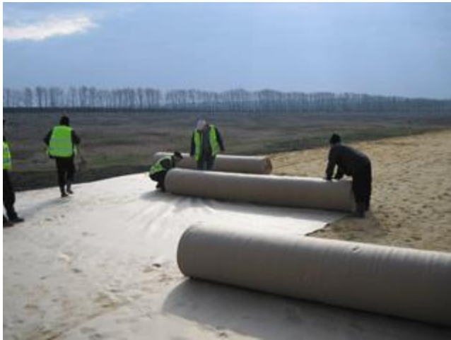
Рисунок 2. Применение геотекстиля в дорожном строительстве.
