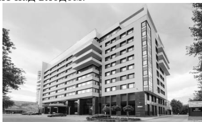
Рис. 3. Офисное здание ул. Кузнецкая, г. Екатеринбург
