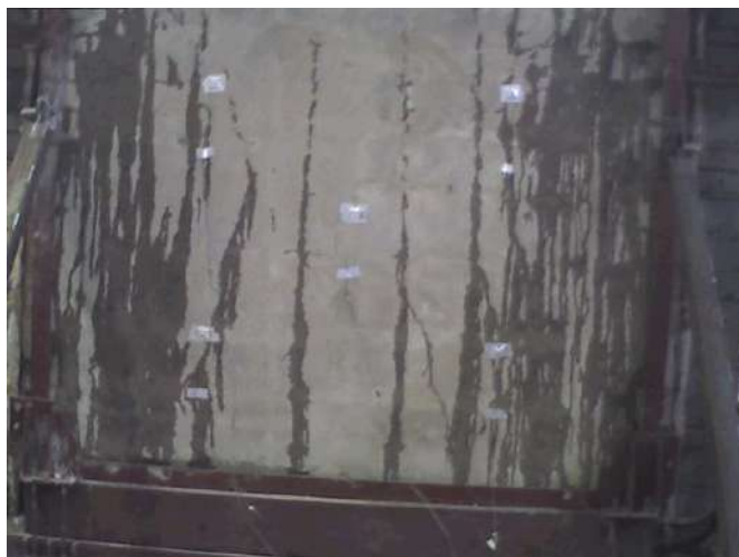
Выступление влаги на вертикальных трещинах на необогреваемой поверхности плиты (время испытания - 30:27)
