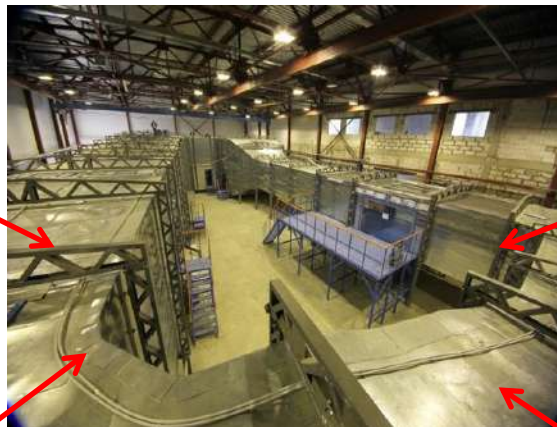
Испытательный стенд «Аэродинамическая труба»
