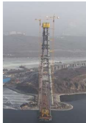
Мостовой переход 1160 м
