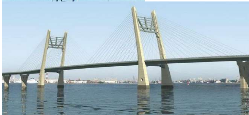
Мост через корабельный фарватер Испытания аэроупругой модели моста
